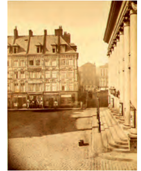
Rue des Manneliers avant son élargissement, 1870
