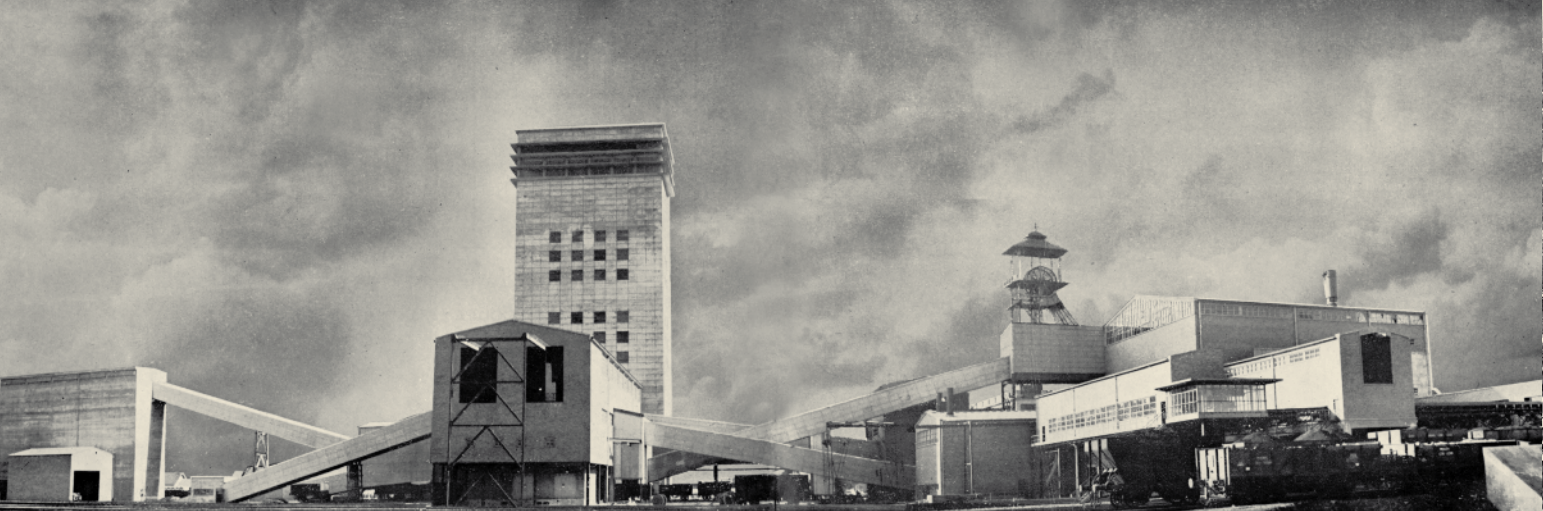
Vue panoramique du système de traitement du charbon du siège de concentration incluant le lavoir (à droite).
