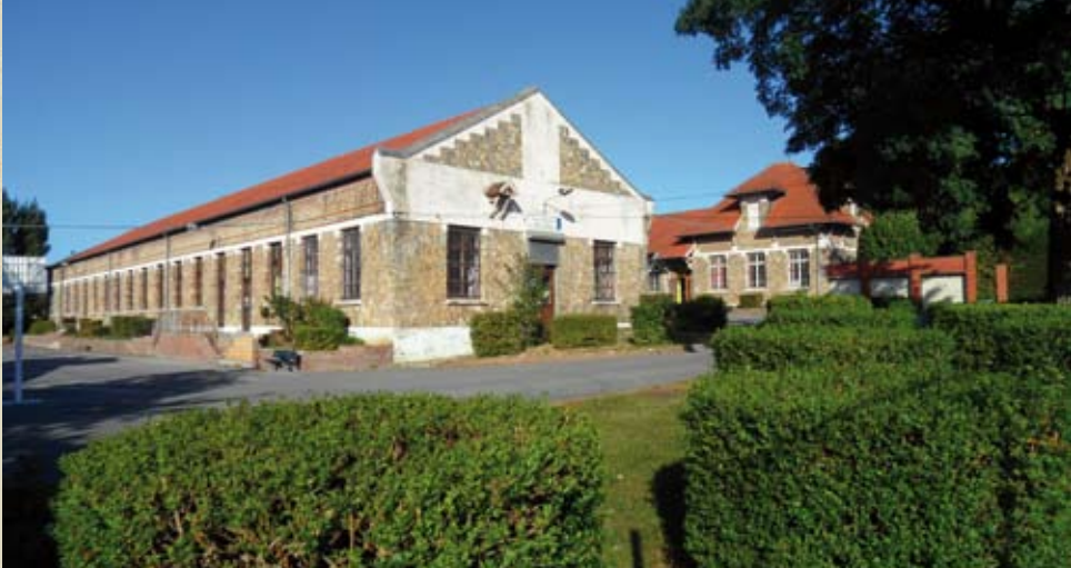
Les écoles témoignent du soin porté à la qualité architecturale des équipements de la cité.
