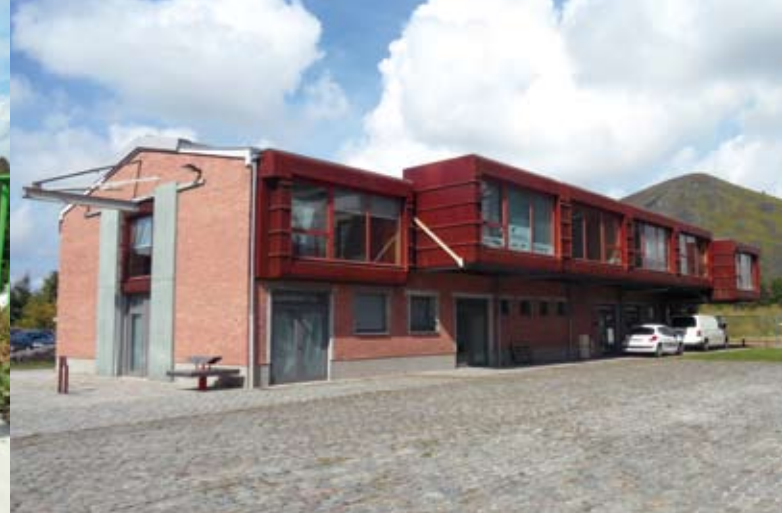
Doté d'extensions habillées d'acier Corten, l'ancien atelier a été réhabilité en pépinière d'éco-entreprises.
