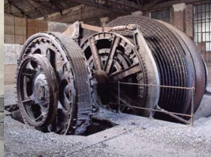
La machine d'extraction à tambour bicylindroconique installée après-guerre est en partie conservée.
