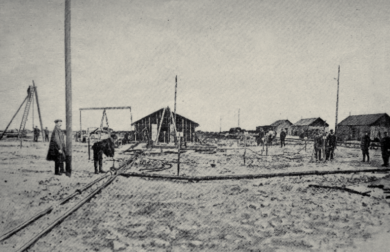
Cliché pris lors des premiers travaux de remise en état du puits 11.
