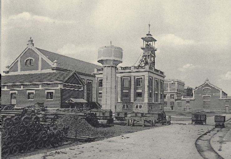
Les nouvelles installations de la fosse 11 en 1925.
