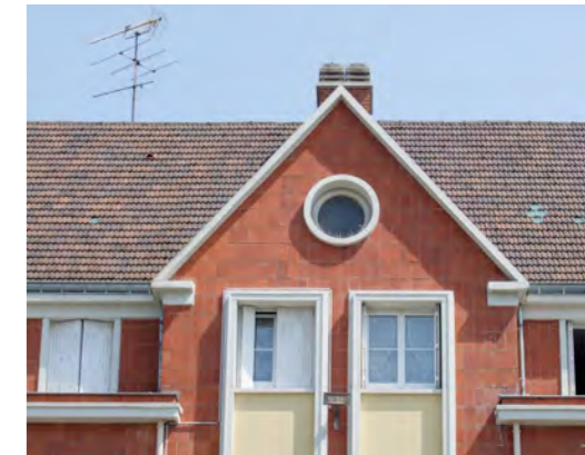
Fronton habillé de carreaux de terre cuite, place des Halles (VAH)
