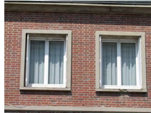
Bandeaux autour de fenêtres, 47 rue de la Madeleine (VAH)
