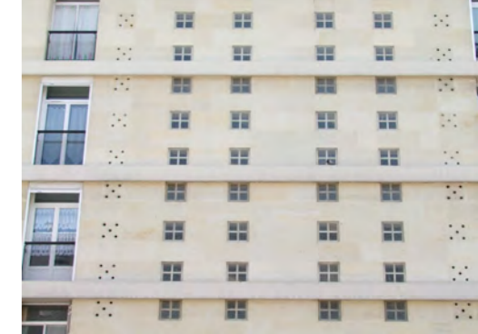
Séchoirs (identifiés par les trous) articulés avec une cage d'escalier distincte par l'alignement de fenêtres, arrière de l'immeuble situé au 2 boulevard Aristide Briand (VAH)
