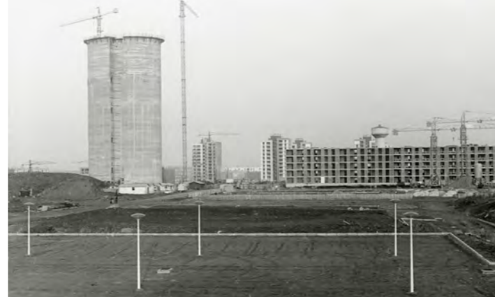
Construction du quartier Argentine et du château d'eau, « Place ZUP » Photographie de Fernand Watteuw, avril 1967 (AD60 - 30 Fi 10/521/1)
