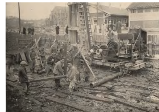
Ouvriers au travail (AMB)
