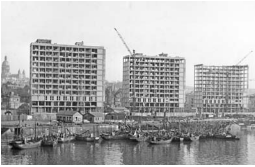
Le chantier des buildings vers décembre 1953 ; Pierre Vivien architecte et Eugène Mopin ingénieur. Archives municipales.
