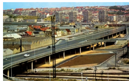
Le viaduc Jean Jaurès aménagé en 1962.
