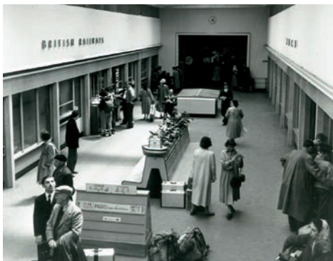
La gare maritime : la salle des pas-perdus.
