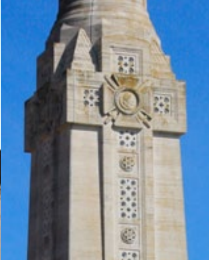
Detail van de daklantaarn.
