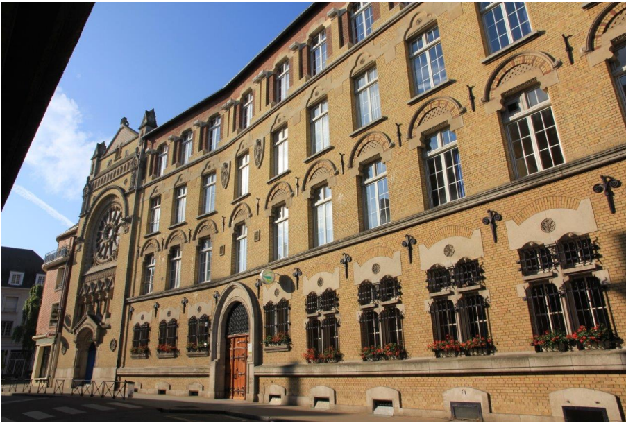
Le lycée Saint-Remi © S. Crampon
