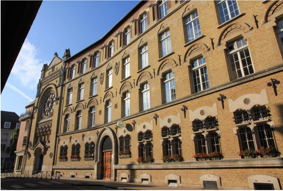
Le lycée Saint-Remi © S. Crampon
