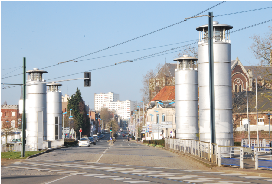
Pont Hydraulique © Virginie Pollet
