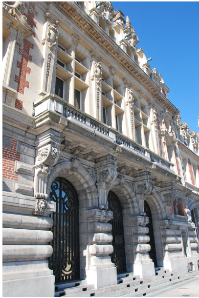
Vue partie basse Chambre de commerce © Virginie Pollet
