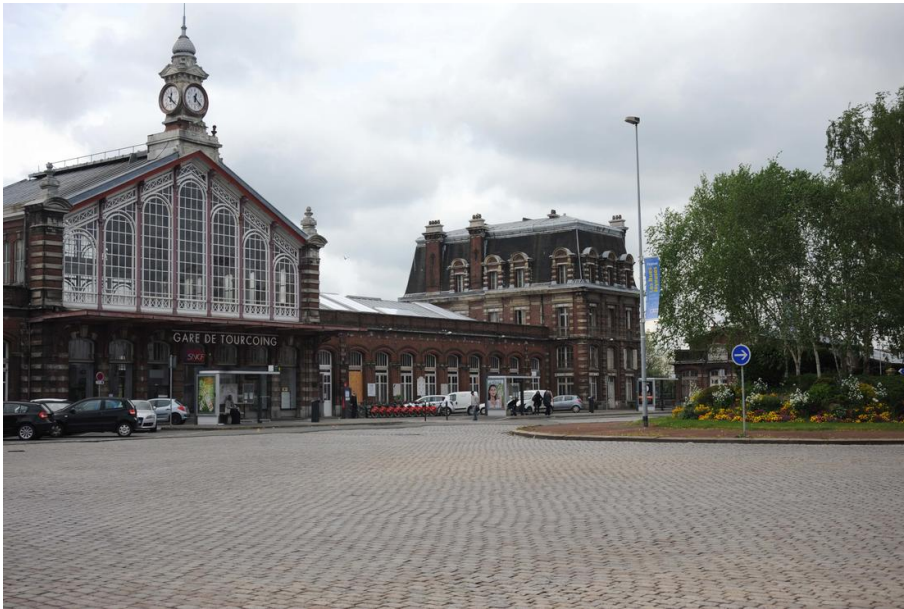
Vue générale Gare © Ville de Tourcoing
