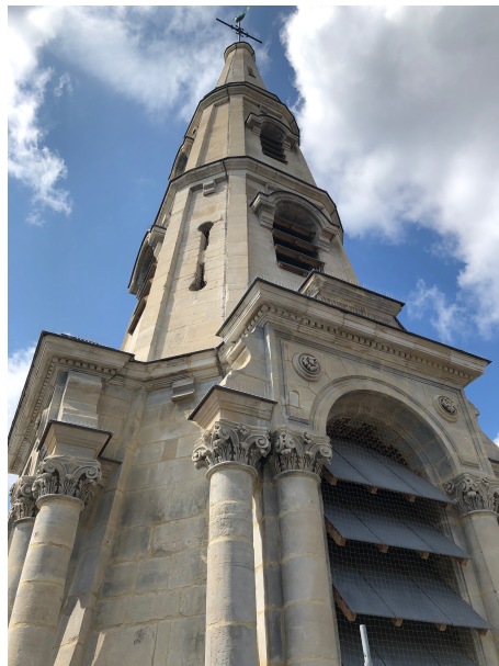
Tour du clocher, 2019 © Philippe Boiteau de chez Battais Charpente
