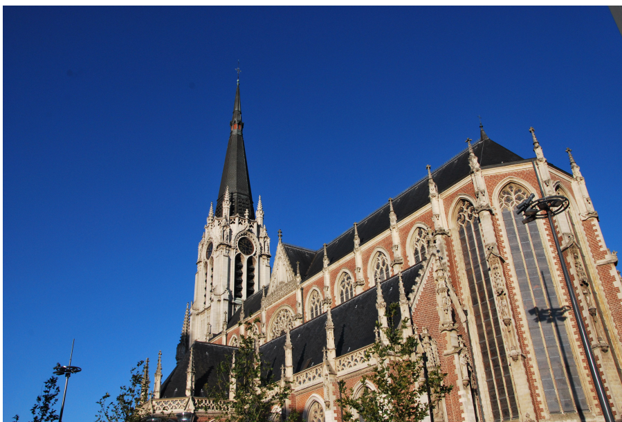
Vue extérieure du chœur © V.Pollet
