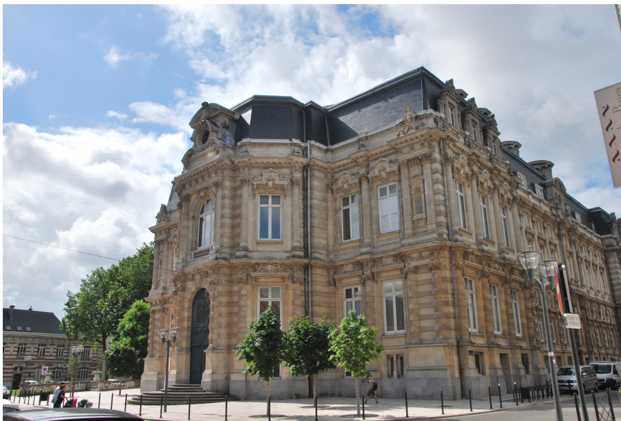
Façade arrière © Virginie Pollet
