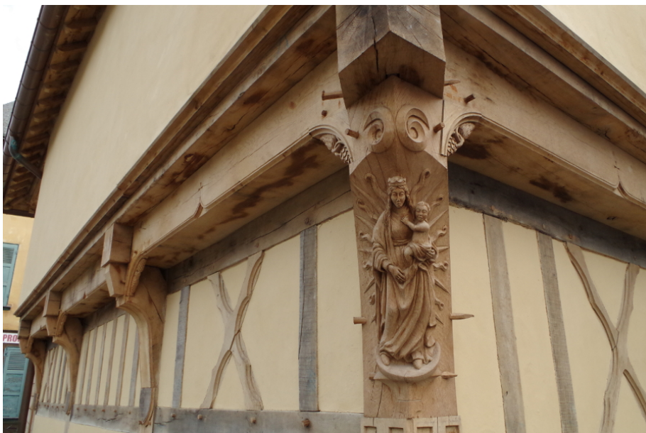
Statue de la Vierge à l'Enfant, localement appelée la Vierge aux rayons, sur le poteau cornier à l'angle de la façade nord du moulin ©AMAH
