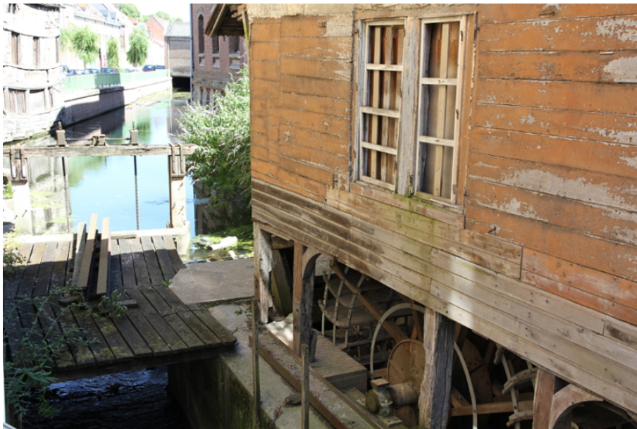
Etat du moulin avant le chantier de sauvetage ©AMAH
