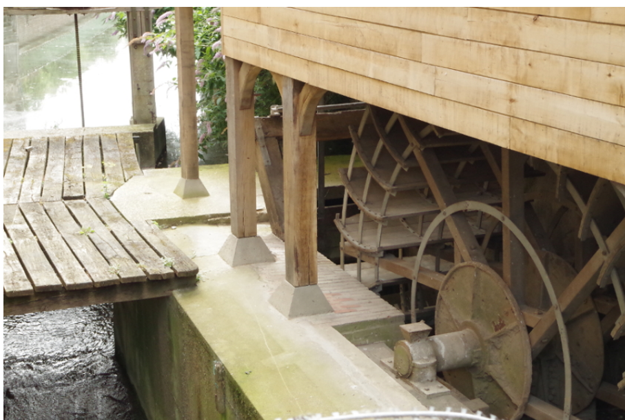
Le Moulin Passe-Avant doit son nom à sa puissante roue qui lui donnait la priorité, lors des opérations hydrauliques, sur le Moulin Passe-Arrière, son voisin du canal des Clairons ©AMAH
