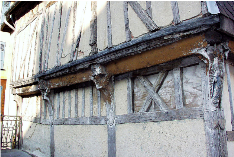
Aperçu du moulin avant sa prodigieuse restauration © ©AMAH
