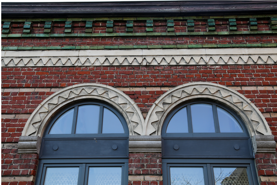
Détail fenêtre de l'Hospice d'Havré © Virginie Pollet
