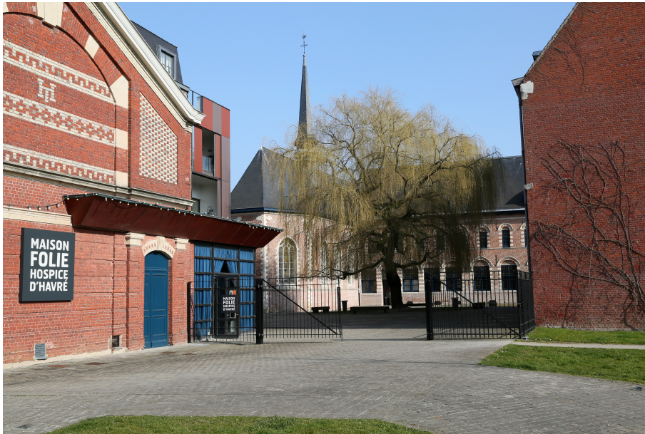
Vue générale de l'Hospice d'Havré © Virginie Pollet
