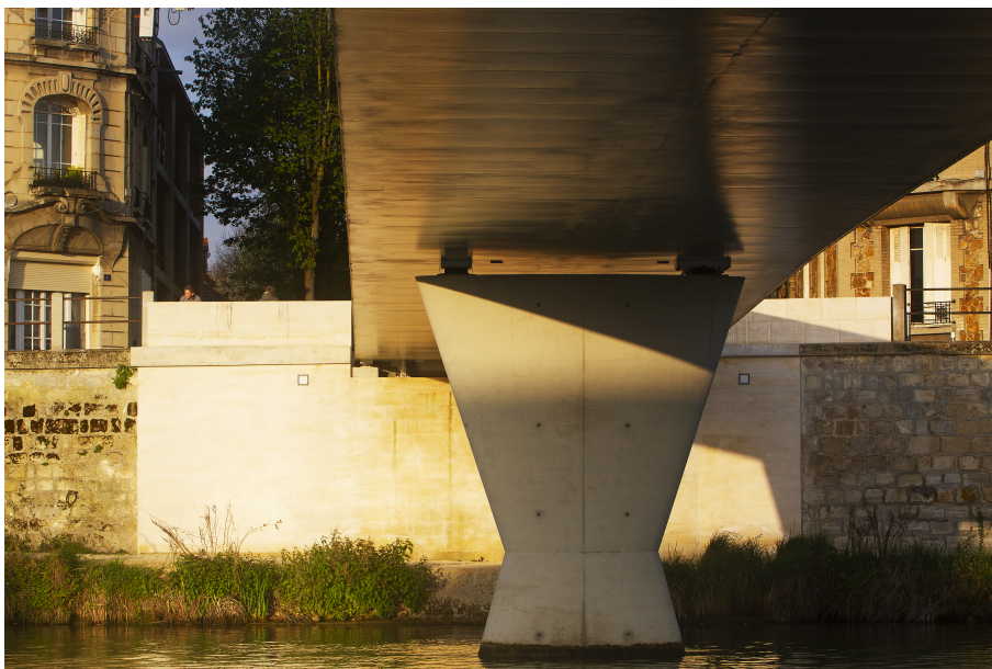
Détail d'un pilier supportant la passerelle des Anglais © Frédéric Sartiaux/Ville de Soissons
