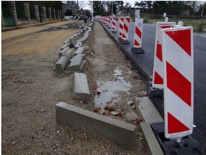
Travaux en cours, détail © Soissons Ville d'art et d'Histoire
