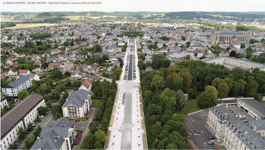
Vue aérienne du boulevard Jeanne-d'Arc en cours de rénovation, 2012 © Benoît Houdry
