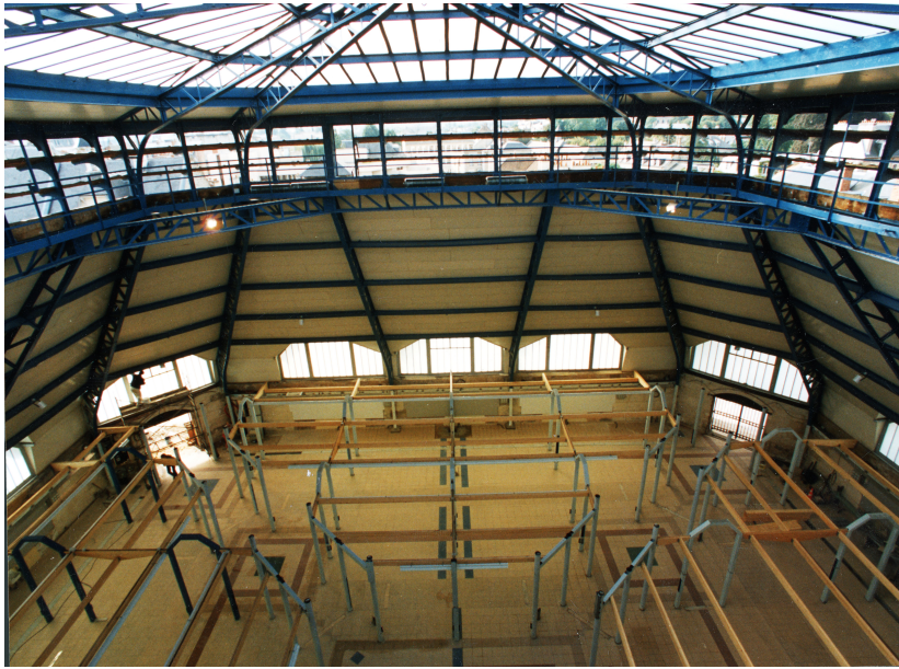
Vue de la structure métallique du marché couvert © Ville de Soissons
