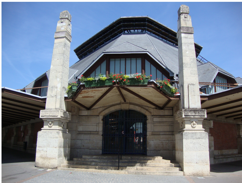
À ses quatre angles, l'accès à l'intérieur du marché couvert est rythmé de deux obélisques qui jouent aussi un rôle de confortement de l'édifice © Soissons Ville d'Art et d'Histoire
