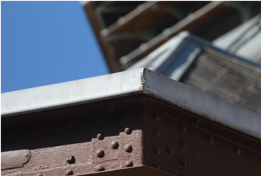
Détails de la structure métallique du marché couvert reprenant les concepts mis en œuvre par Gustave Eiffel © Frédéric Sartiaux/Ville de Soissons
