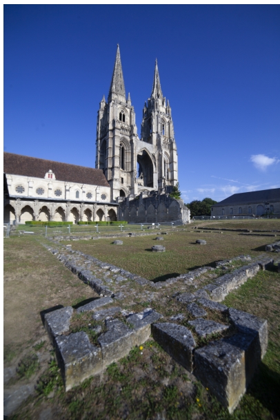
Vue générale du site prise de l'est © Frédéric Sartiaux
