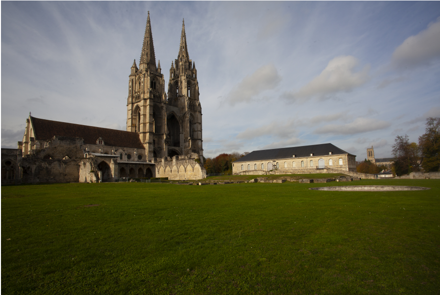
Cloître et façade de l'église abbatiale, vue de l'est © Frédéric Sartiaux
