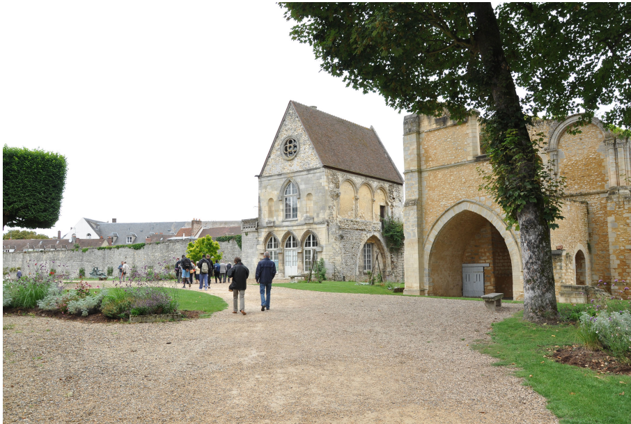
Vue extérieure des appartements royaux et de la tour transformée en oratoire PAH de Senlis à Ermenonville
