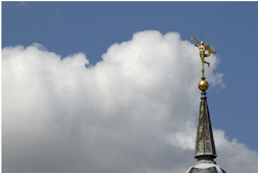
Pivotant sur un axe et culminant à 52 mètres, l'Ange de la Renommée en cuivre doré (surnommé Ch'l'Ange par les Amiénois) sert de girouette. © J. Feray
