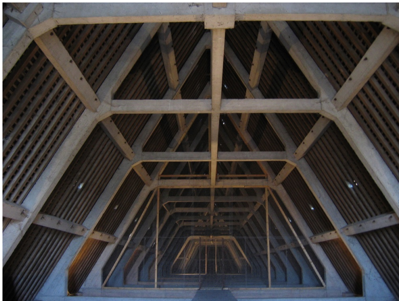
La charpente en béton aujourd'hui © ville de Noyon
