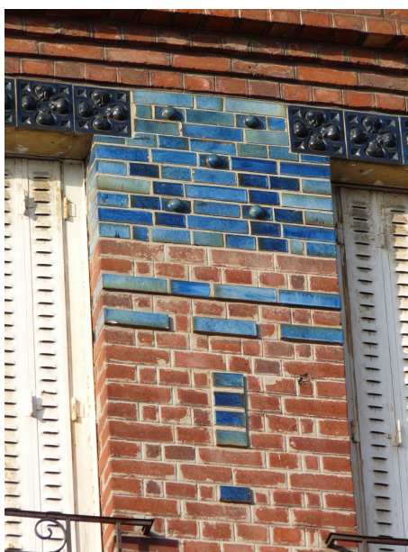
5. Détails de briques vernissées, place Aristide Briand © ville de Noyon
