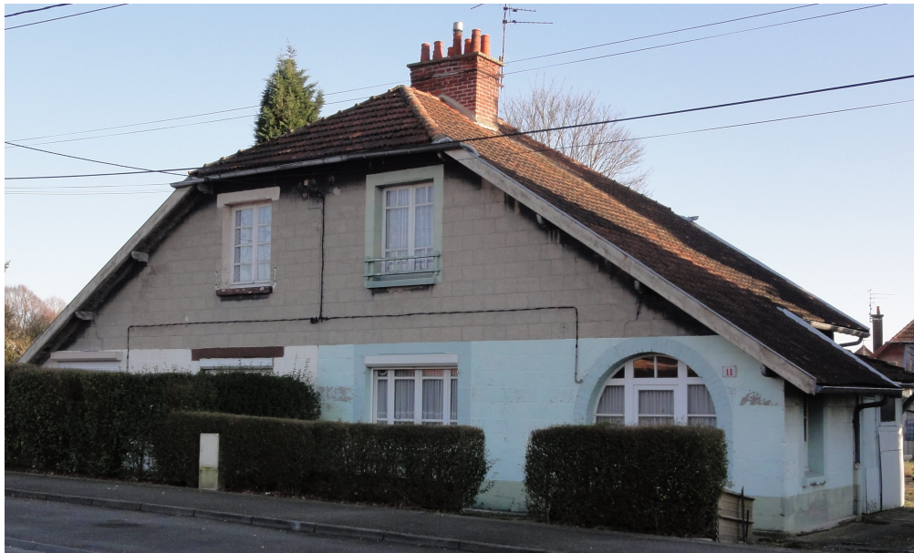
Logement 3 ©SVAH Lille
