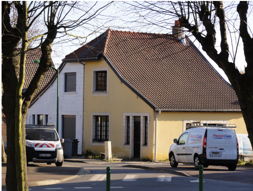
Logement 2 ©SVAH Lille
