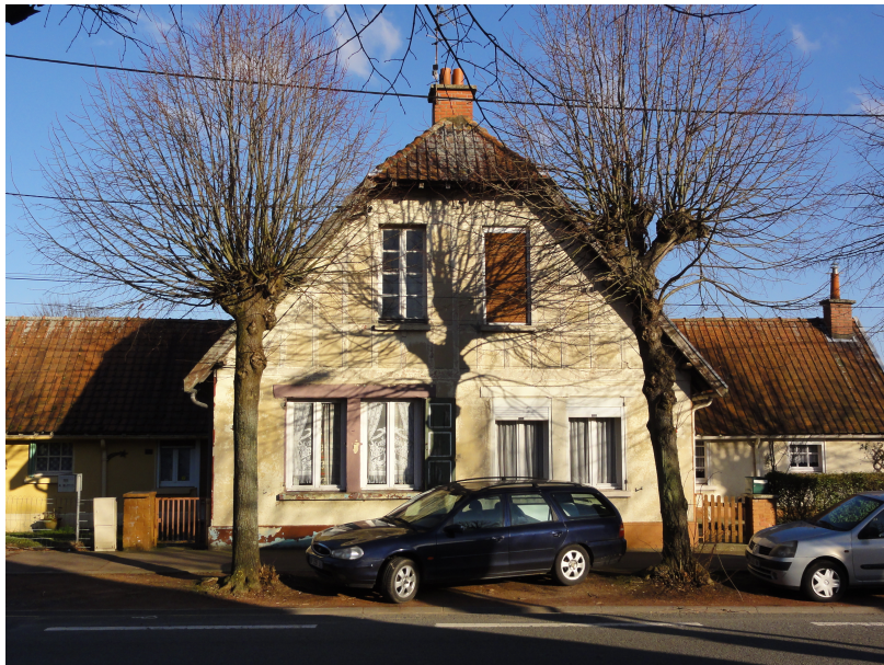
Logement 1 ©SVAH Lille
