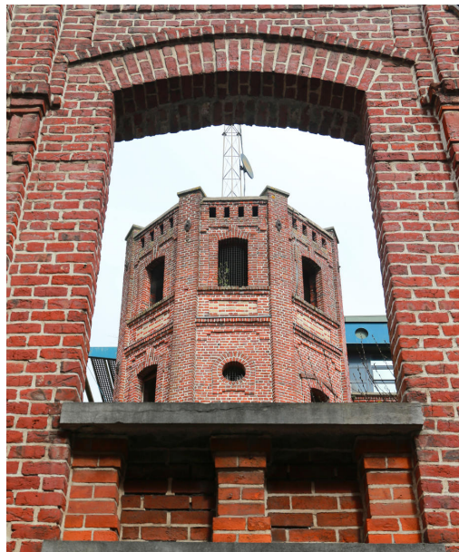
Détail de l'IUT : la tour "crénelée" © Ville de Tourcoing
