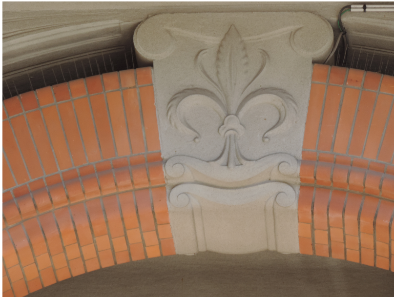
Détail béton moulé ©SVAH Ville de Lille
