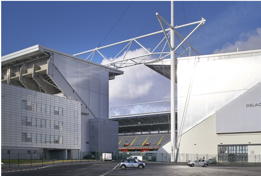
Vue extérieure du stade. © Lanoo Photographe / Cardete & Huet Architectes / Atelier Ferret Architectures
