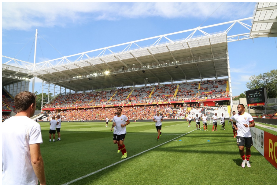
Vue intérieure du Stade Bollaert-Delelis. © RCLens
