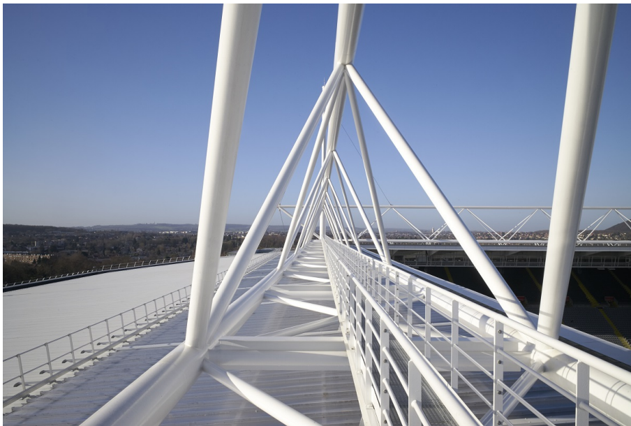
Détail de la nouvelle toiture. © Lanoo Photographe / Cardete & Huet Architectes / Atelier Ferret Architectures
