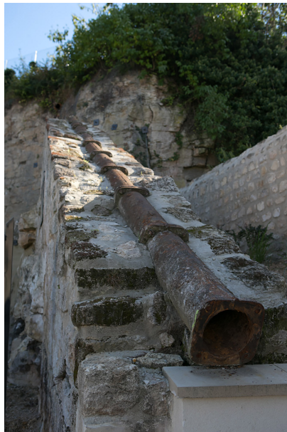
La canalisation reliant le Pavillon de Manse au réservoir
