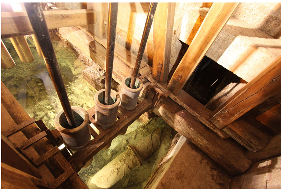
Puit souterrain de la Machine de Manse © M. Savart
