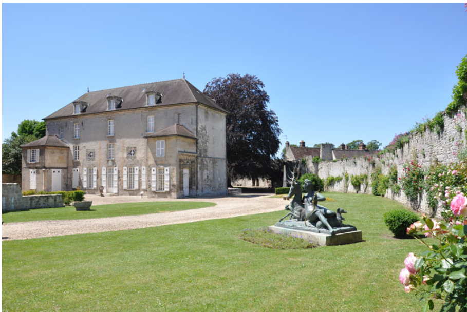
Prieuré (logis du prieur, actuel musée de la Vénerie) vu depuis le parc du château royal ©Ville de Senlis
