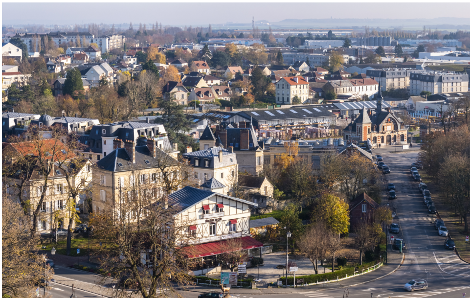
Perspective sur la gare à droite ©Pierre de Montalte
