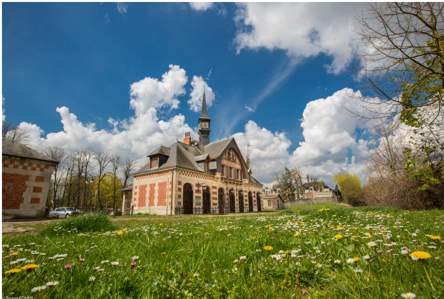
Perspective depuis la voie verte construite sur les anciens rails ©Ville de Senlis
