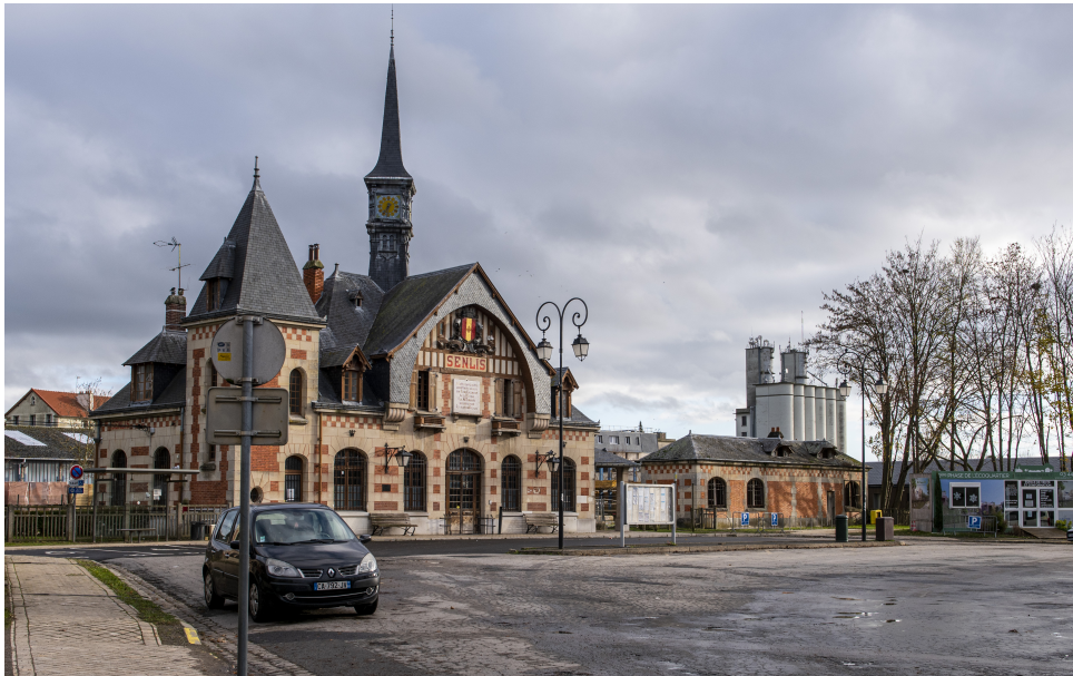
La gare de Senlis, fronton ©Pierre de Montalte
