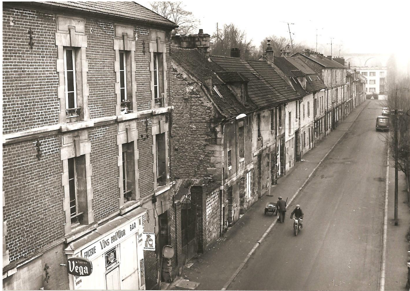
Logements insalubres du quartier de la Canardière à Chantilly, vers 1950
