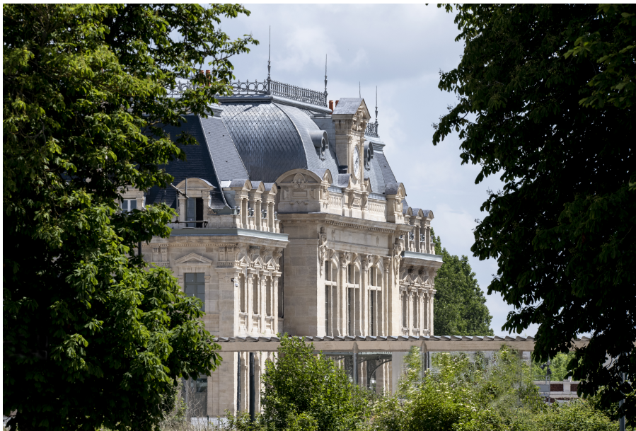
La gare rénovée © Carl Peterolff
