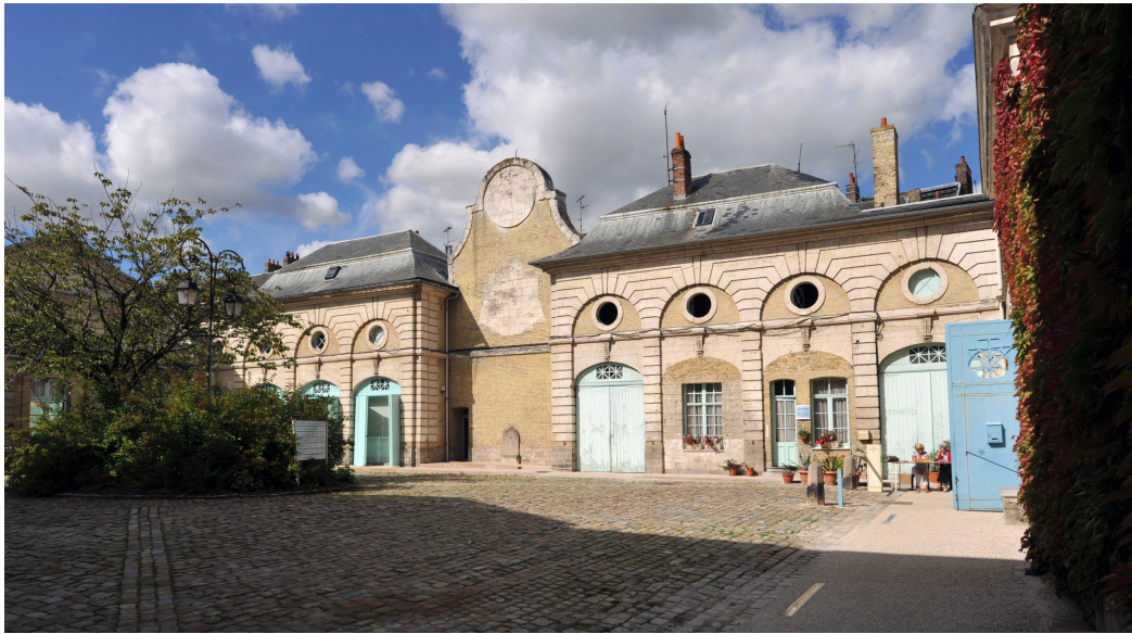
De gauche à droite le logement du personnel, les écuries séparées par le mur et le portail © Carl Peteroff
