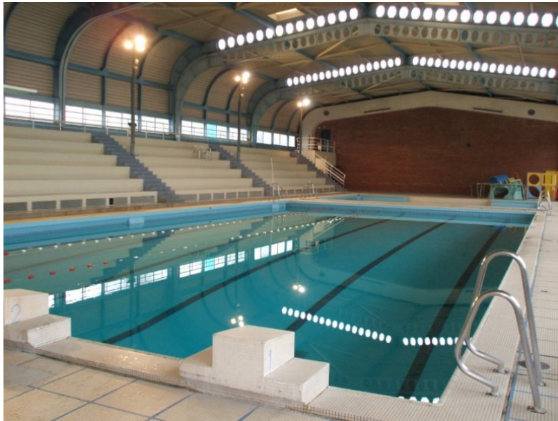
Vue de la piscine avec la charpente métallique fermée © Ville de Noyon
