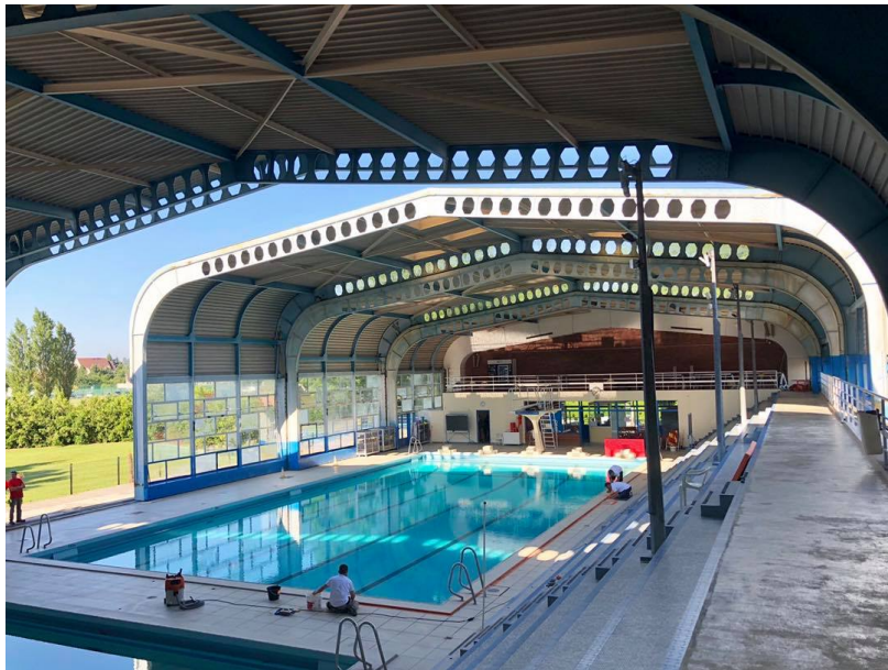
Le toit en cours d'ouverture © Ville de Noyon
