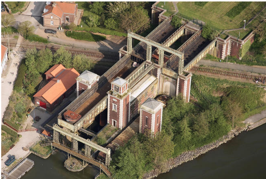
Vue aérienne de l'ascenseur à bateaux © DR
