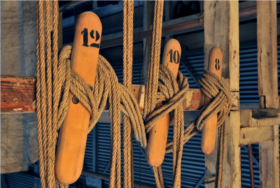
Les palettes originales pour accrocher les fils suspendant les décors © Carl Peterloff
