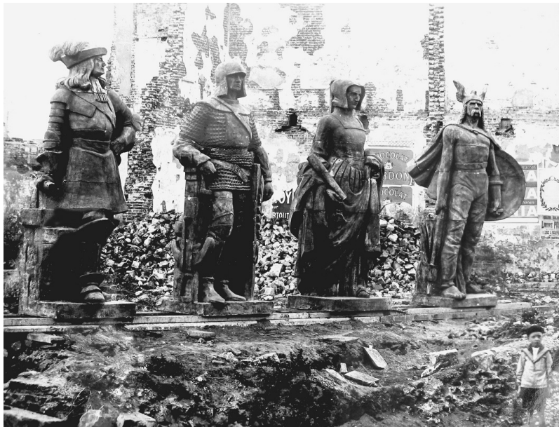
Les statues du beffroi avant leur installation dans les années 1920 © Le Labo
