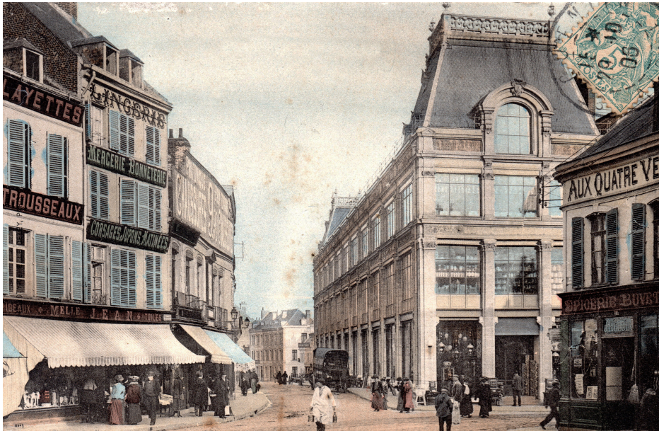
Vue du carrefour des Quatre-Vents avant 1910 © carte postale, collection particulière
