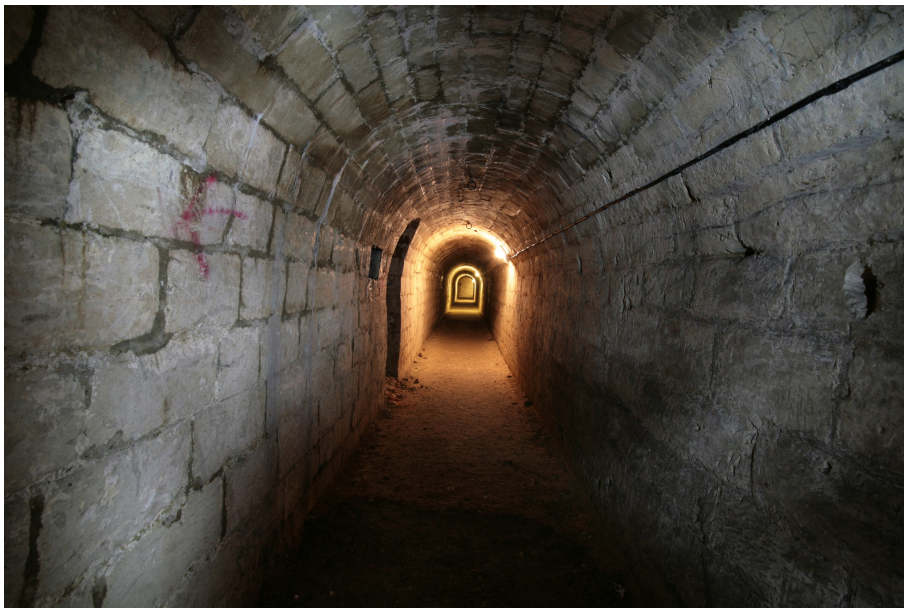
Les galeries souterraines de la citadelle © Déclic
