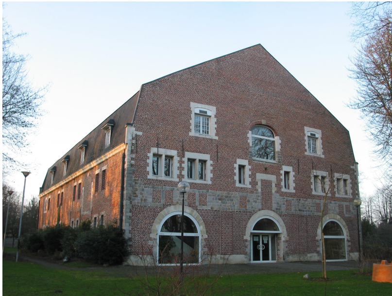
L'ancien arsenal Balagny de 1581 aujourd'hui salle de sport municipale © Déclic
