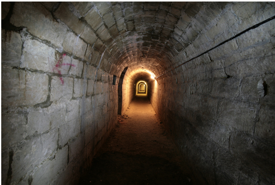
Les galeries souterraines de la citadelle © Déclic
