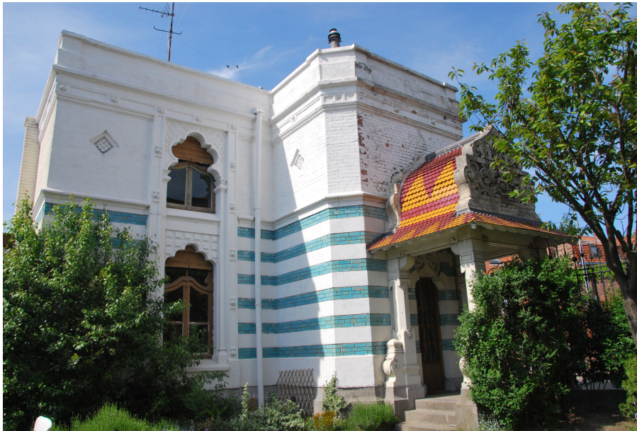
Vue arrière Pavillon d'entrée Vaissier © V. Pollet
