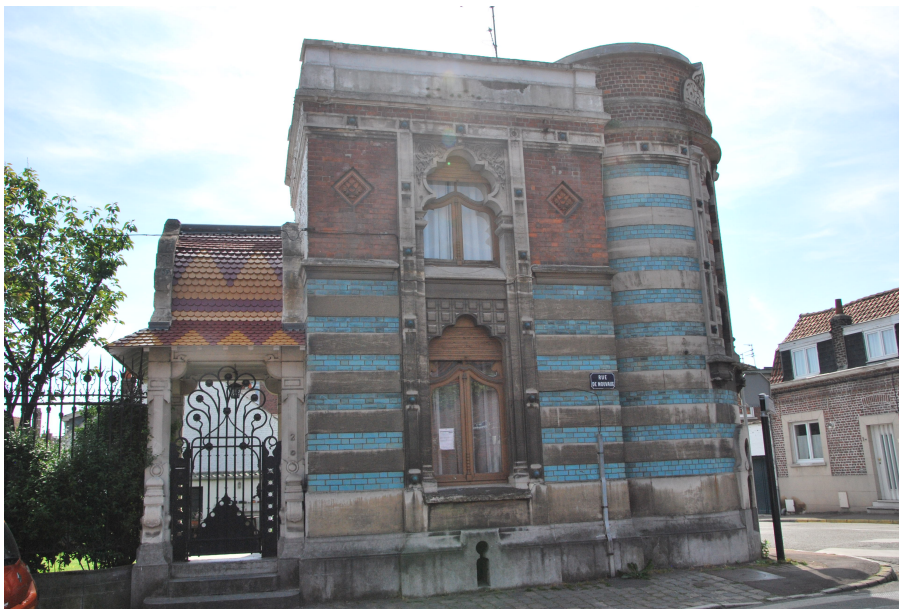
Vue latérale Pavillon d'entrée Vaissier © V. Pollet
