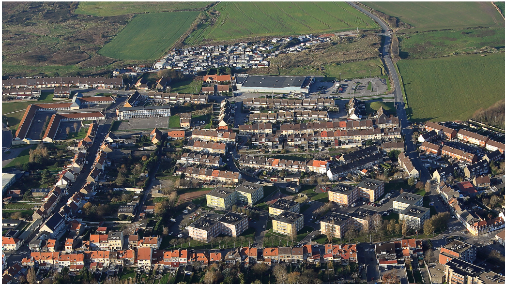
Cité de l'Aiglon, quartier du Chemin Vert Habitat du littoral - Côté Drone
