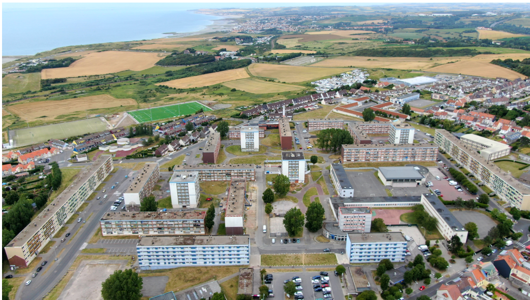
Cité Triennale, quartier du Chemin Vert, Vue aérienne, été 2019 Habitat du littoral - Côté Drone
