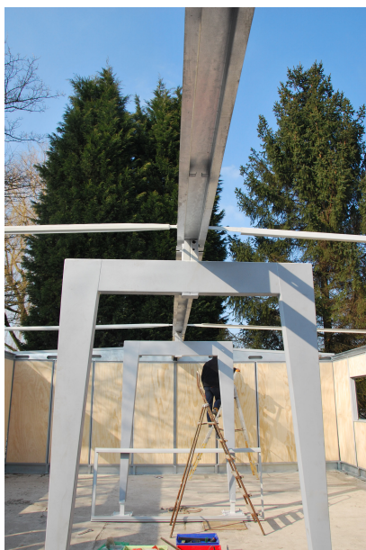
Pavillon Prouvé en restauration, 2013 © Virginie Pollet
