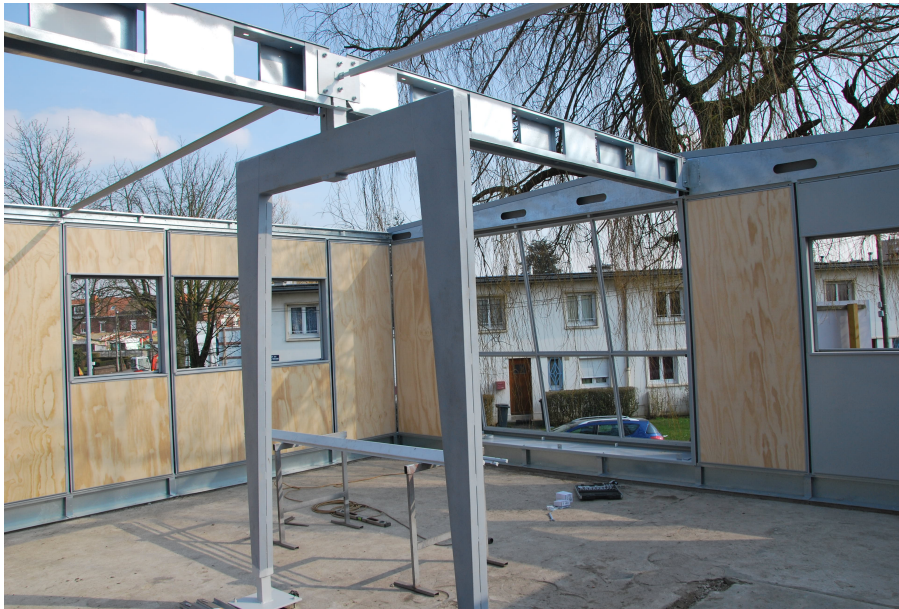
Pavillon Prouvé en restauration, 2013 © Virginie Pollet
