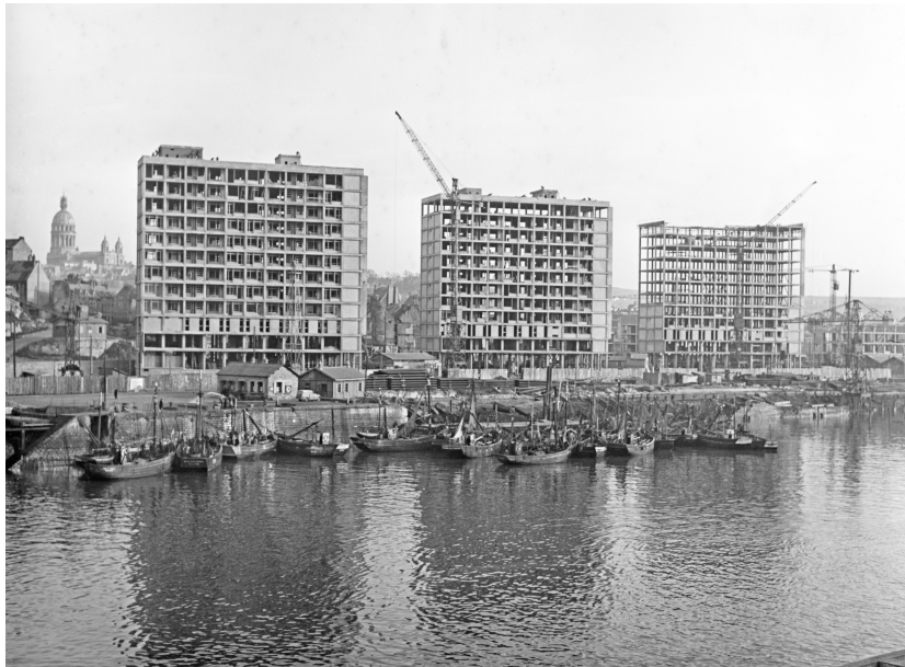
Le chantier des buildings vers décembre 1953 : Pierre Vivien architecte et Eugène Mopin ingénieur - Fonds photographique de la Chambre de Commerce et de l'Industrie de Boulogne-sur-Mer (versé aux Archives municipales) Archives municipales de Boulogne-sur-Mer
