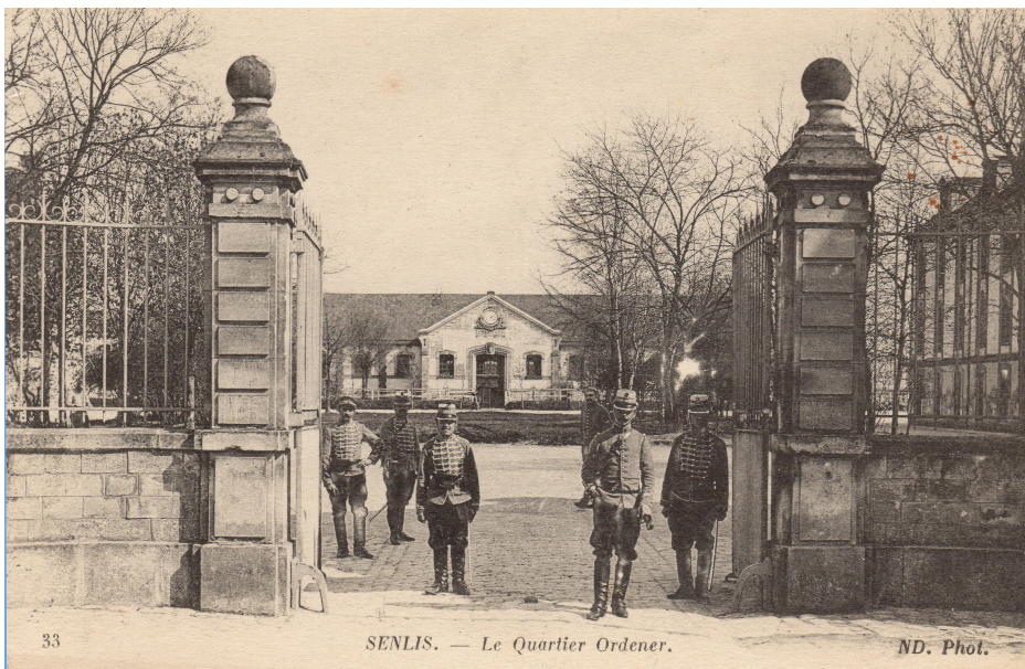
Carte postale, photographie vers 1900, perspective entrée principale du Quartier Ordener depuis la rue du Faubourg Saint-Martin ©Ville de Senlis
