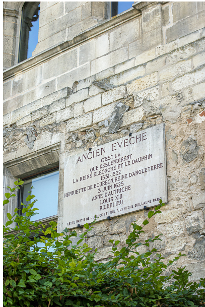
Détails façade ancien palais épiscopal, plaque commémorative visible depuis le jardin de l'évêché ©Ville de Senlis
