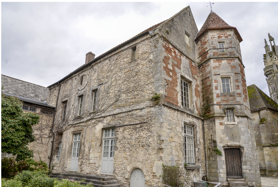
Hôtel de Vermandois, vue d'ensemble depuis l'extérieur de l'édifice ©Ville de Senlis
