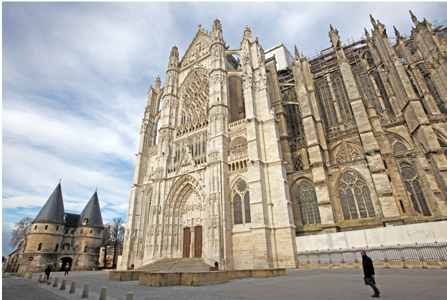
Chœur et transept de la cathédrale Saint-Pierre, et la porterie d'entrée du palais épiscopal, actuel MUDO-Musée de l'Oise © JF. Bouché – Dir. de la communication, Ville de Beauvais
