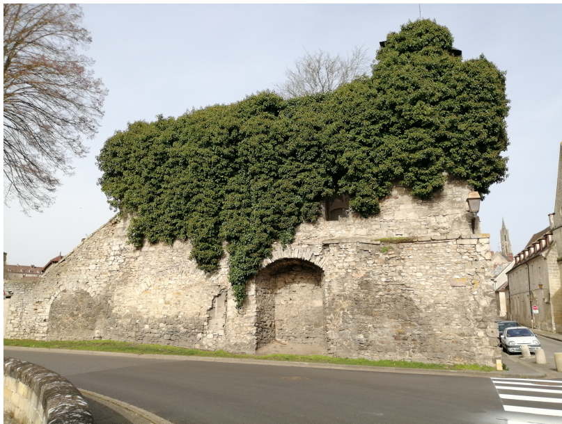
Vestiges des fortifications de la Porte de Paris démantelé au 19ème siècle, aujourd'hui cet ensemble fait partie d'une habitation privée ©Ville de Senlis
