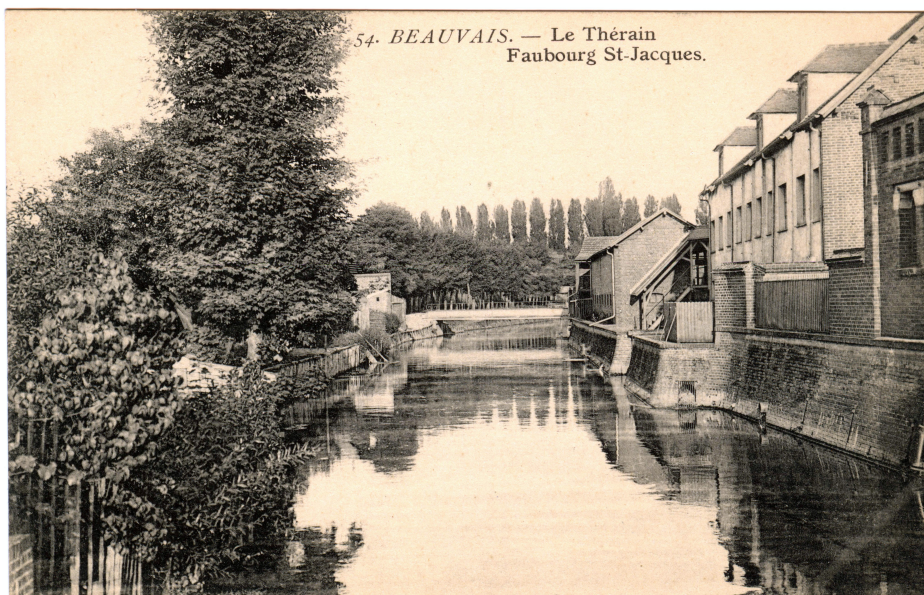
L'activité industrielle du Thérain. Les abords de l'usine La Brosse et Dupont le long de la rivière. Carte postale ancienne © Réseau des médiathèques du Beauvaisis
