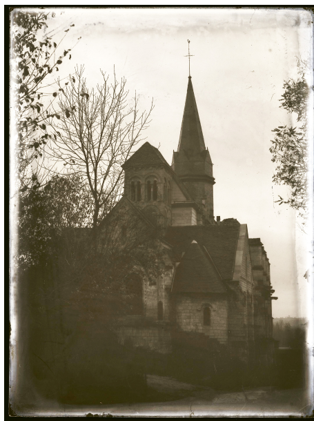
L'église Notre-Dame de Marissel, photographie ancienne non datée / © Collection de la Ville de Beauvais, dépôt aux Archives départementales de l'Oise (EDT 294/S16)
