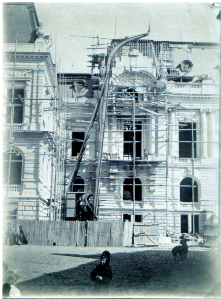
Construction du Palais de Fervaques : grue à vapeur servant au levage des pierres ©Ville de Saint-Quentin
