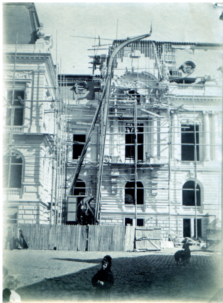
Construction du Palais de Fervaques : grue à vapeur servant au levage des pierres ©Ville de Saint-Quentin
