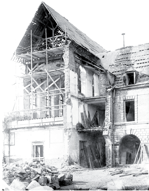
Chantier de démolition de l'abbaye de Fervaques (1893-1896) : l'église éventrée et l'aile nord du cloître ©Ville de Saint-Quentin
