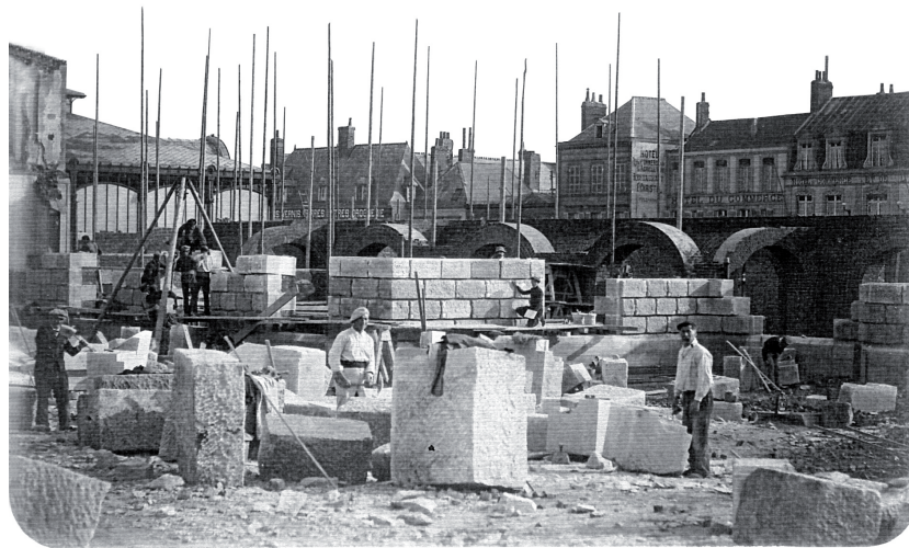
Pose du soubassement du Palais de Fervaques, 1897 ©Ville de Saint-Quentin
